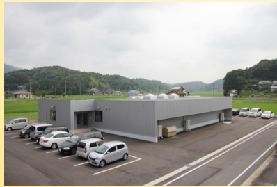
4月竣工の厨房棟
